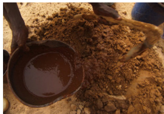
写真⑨ダバ(手鋏)を使って土と溶いた牛糞をよく混ぜる
