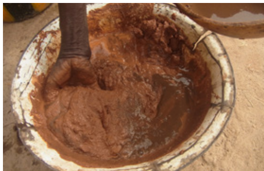
写真②手に乗せて下から上に擦りつけると、びたーっと塗れる 写真③ラテライトと牛糞を混ぜ、小石など手に当たれば取り除く
